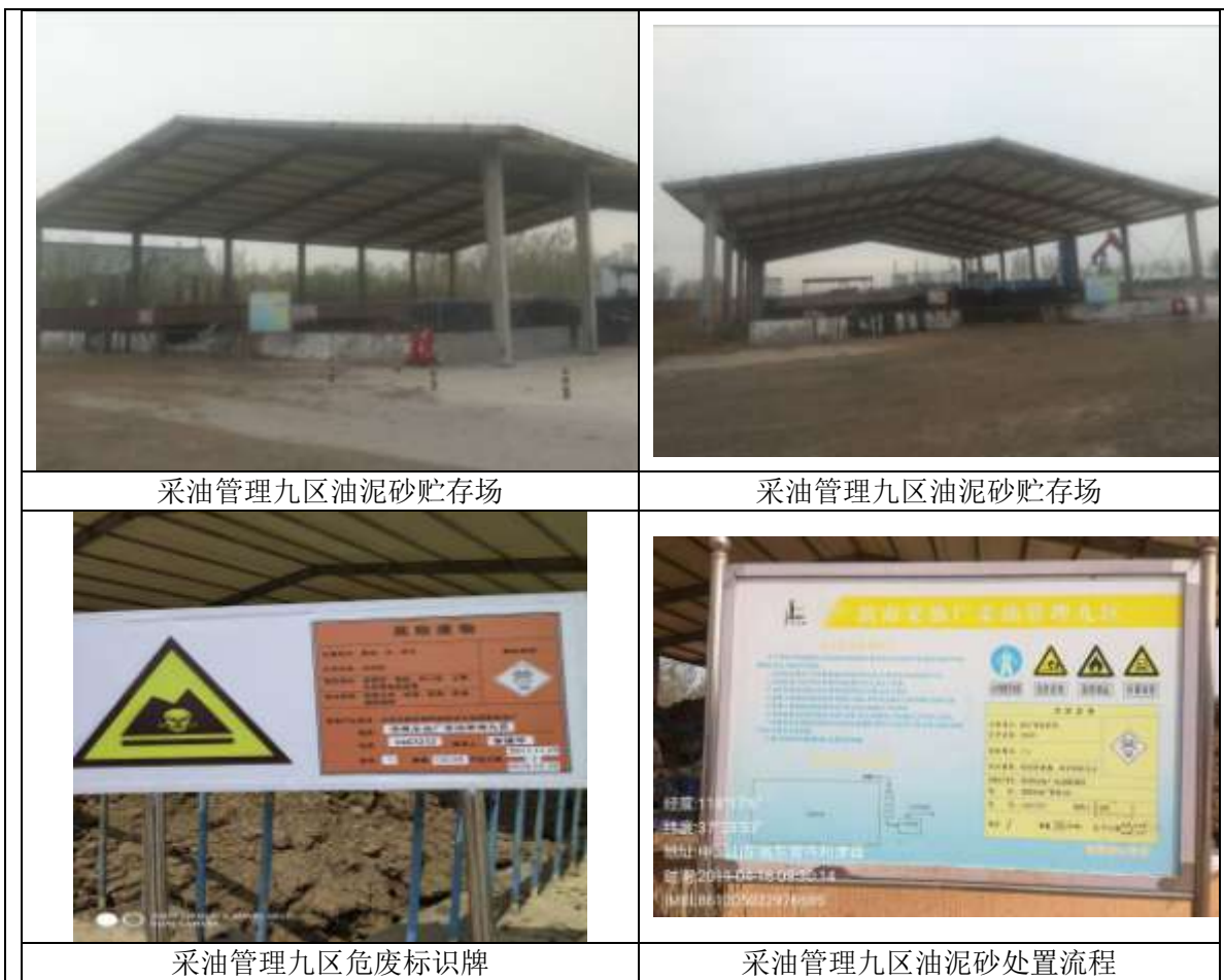
图 5-5 油泥砂贮存情况
