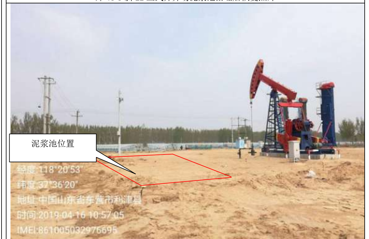
郑 41-1-斜 24 井场泥浆池治理后恢复照片
