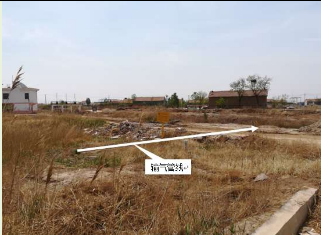
陈北水库段管线
