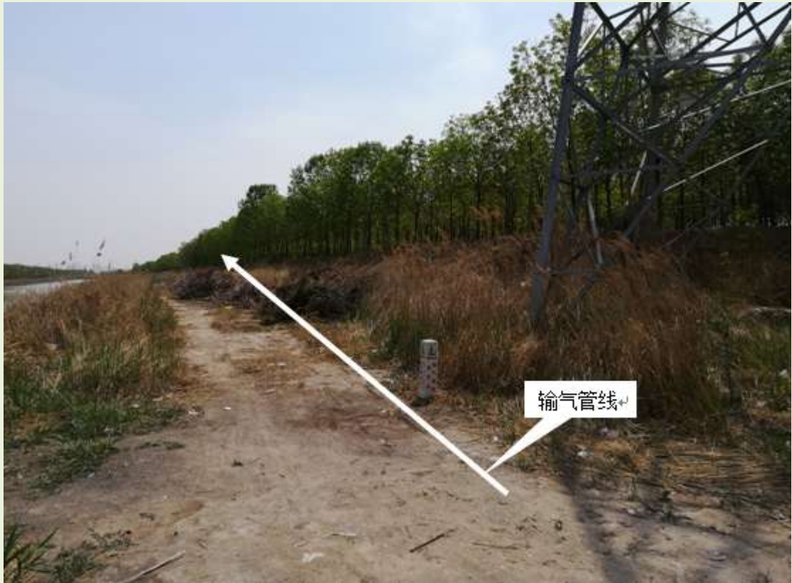
垦利县黄河路东侧段管线
