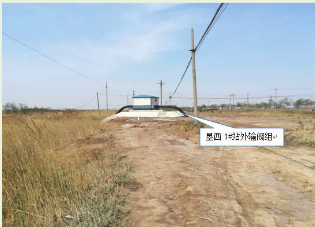
新建垦西 1#站外输阀组
