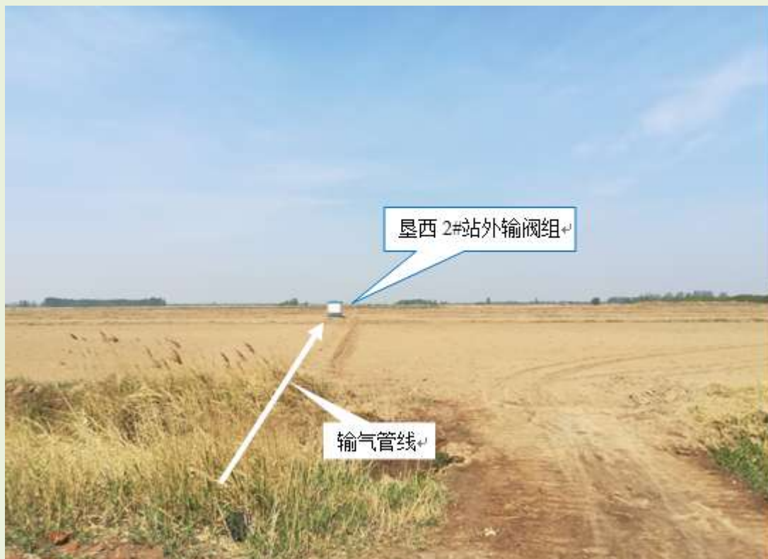
新建垦西 2#站外输阀组
